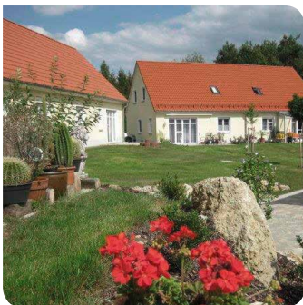
Senioren-Wohnanlage mit Betreuung in Pottenstein.
