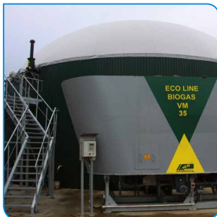
Biogasanlage in Hohenlockstedt.
